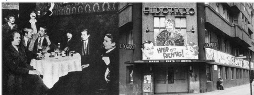
links: Innenansicht, 1920 rechts: Außenansicht, 1932
